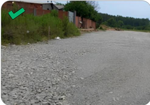
*Recomposição de pavimento primário com material isento de contaminação e uniforme*
