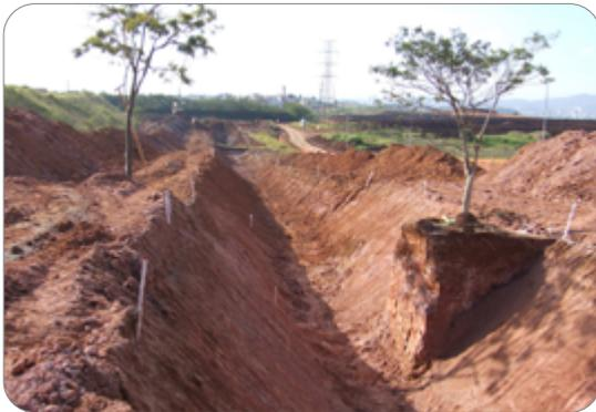
*Escavação em talude com demarcação topográfica da crista*
