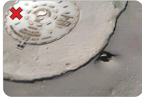
*Erosão do pavimento próximo ao poço de visita*
