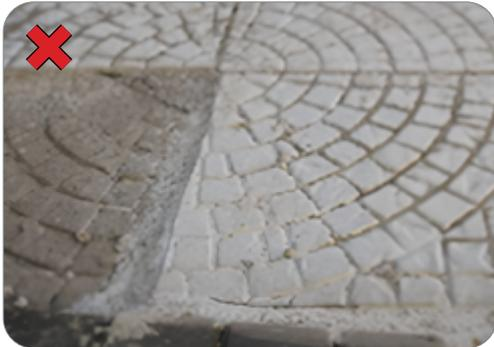
*Placa com excesso de argamassa e desnivelada*
