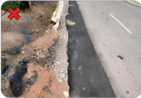
*Exemplo de má execução: não remoção de todo o pavimento danificado*
